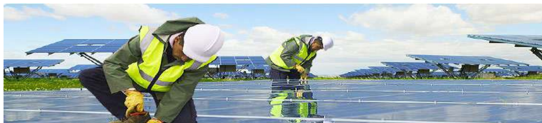
Figura 4 - Capacitação de Profissional (projeto Instalador Qualificado)
